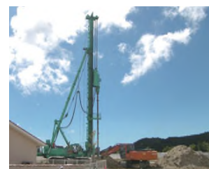
大型機での施工
