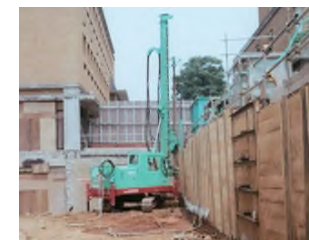
土留め壁内での施工
