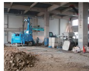
建屋内での施工
