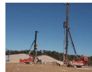
大型機での施工
