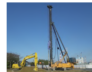
施工全景 (120t級)
