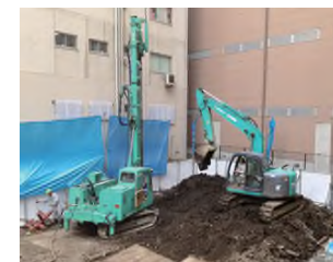
隣地近接施工
