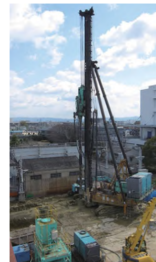
大型機での施工
