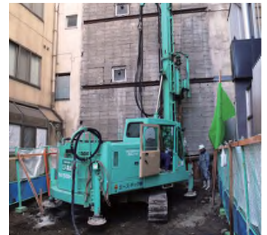
狭小地での施工状況
