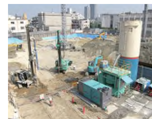
施工全景 (15t級)
