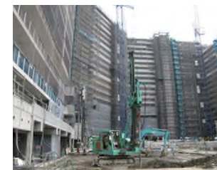
他工程との併行施工
