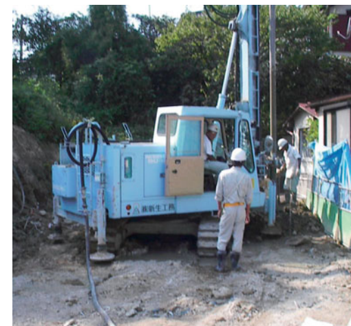
狭小地での施工状況
