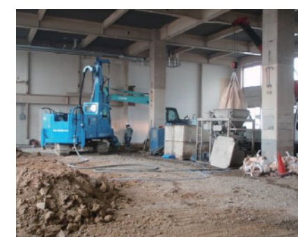
建屋内での施工
