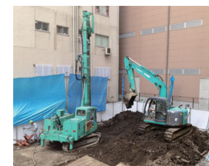
隣地近接施工
