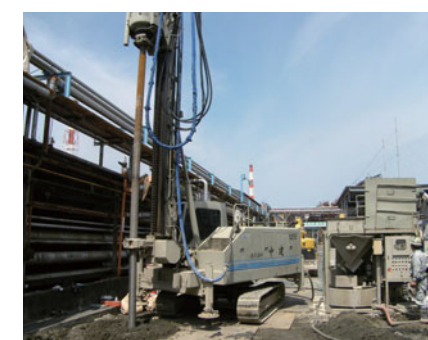
工場敷地内での施工
