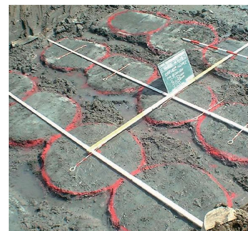
改良コラム頭部状況
