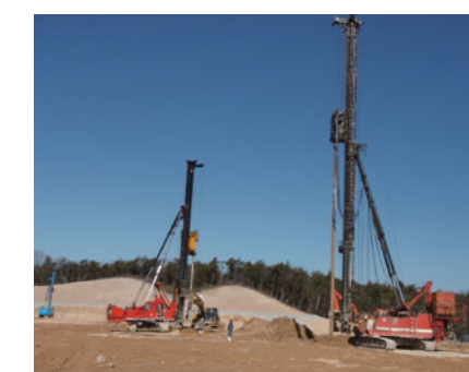
大型機での施工
