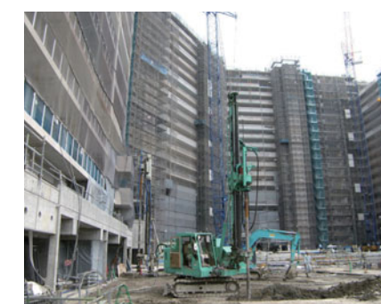
他工程との併行施工
